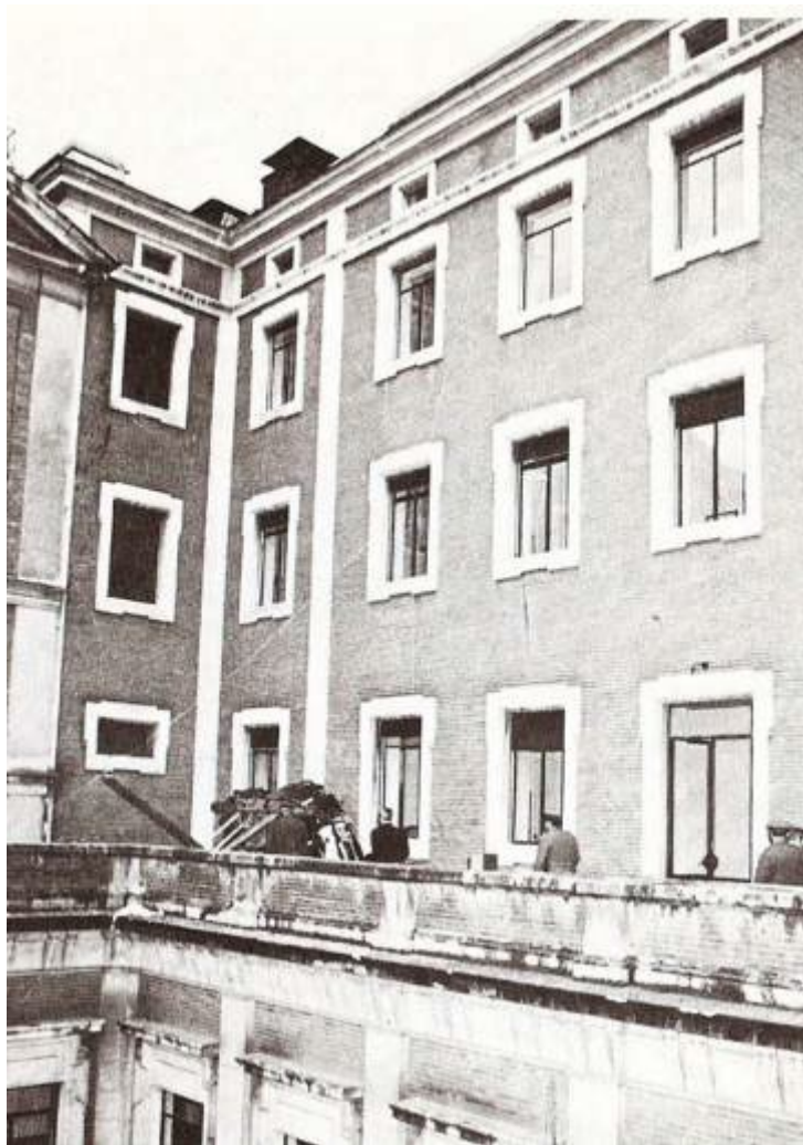
PATIO INTERIOR DONDE CAYÓ EL COCHE DE CARRERO BLANCO
